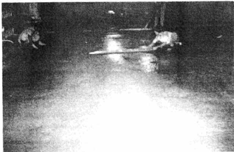
รูปที่ 3.15 การแต่งผิวหน้าคอนกรีตแข็งตัวเร็ว
