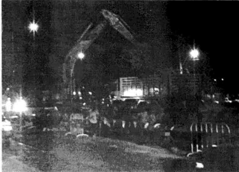
รูปที่ 3.10 ใช้รถ Back-Hoe ตักคอนกรีตที่ทُبอบออกแล้วนำไปทิ้ง
