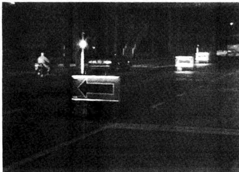
รูปที่ 3.7 ติดตั้งป้ายจราจรเพื่ออำนวยความสะดวกและปลอดภัย
