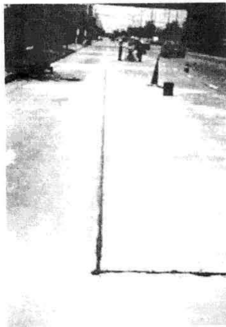
รูปที่ 3.17 ใช้วัสดุอุดรอยต่อตลอดแนว
