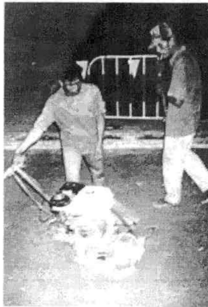
รูปที่ 3.11 ปรับระดับให้แน่นก่อนการเทคอนกรีตแข็งตัวเร็ว
