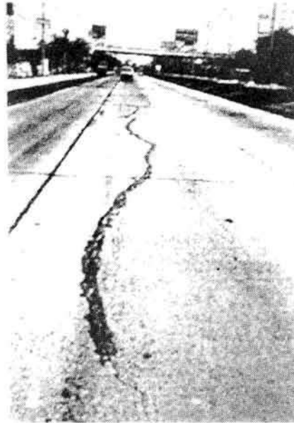
รูปที่ 3.6 สภาพถนนที่ต้องซ่อมบำรุงด้วยคอนกรีตแข็งตัวเร็ว
