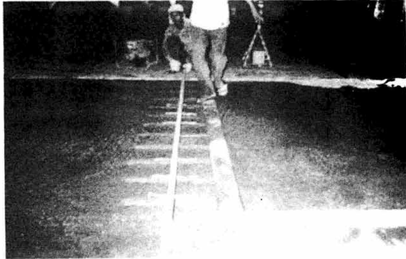
รูปที่ 3.14 คอนกรีตแข็งตัวเร็วจากโรงงานได้ถูกนำมาเทลงบริเวณซ่อมบำรุง และการวางเหล็กรอยต่อ
